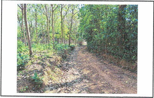
ก่อสร้างถนน คสล.สายสมบัติพัฒนา ม.2
