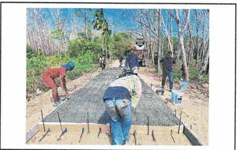
ก่อสร้างถนน คสล.สายทางเข้าหลังโรงเรียนแหลมงอบวิทยาคม(ด้านหลัง) ม.1
