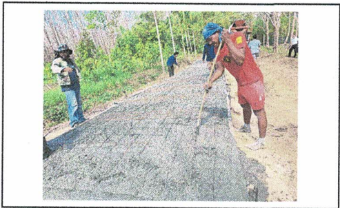
ก่อสร้างถนน คสล.สายทางเข้าหลังโรงเรียนแหลมงอบวิทยาคม(ด้านหลัง) ม.1
