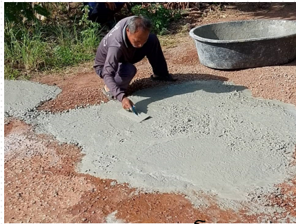
ซ่อมแซมผิวถนนโดยการเทปูน
