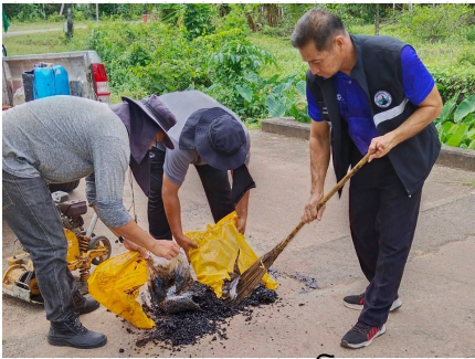
ซ่อมแซมผิวถนนโดยการอัดยางมะตอย
