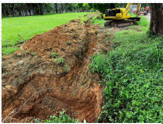
ขุดหลุมสำหรับปักเสา
