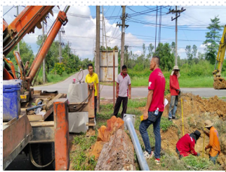
ลงตอม่อและปักเสาไฟ
