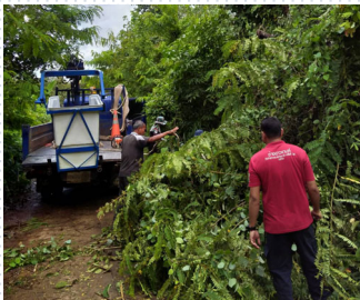
ตัดไม้ล้มขวางถนนที่ ม.2 ระหว่างดำเนินการ
