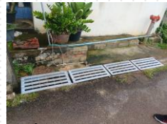
ติดตั้งตะแกรงที่ซ่อมแซม แล้วคืนที่เดิม
