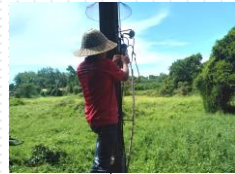
หมู่ 4 เปลี่ยนไฟโถ้แสง ตู้ควบคุมไฟส่องสว่าง
