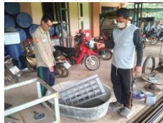
ซ่อมแซมตะแกรงปิด ทางระบายน้ำ ม.5
