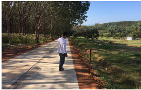
ถนน คสล. สายสระน้ำ อบต.
