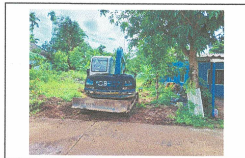
ก่อสร้างถนน คสล.สายเหมินทสูตร ม.6
