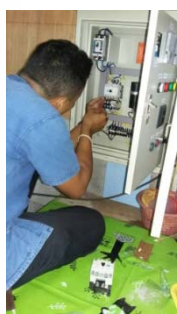
ซ่อมแซมระบบไฟฟ้าปั้มน้ำ ศาลาหมู่ 3
